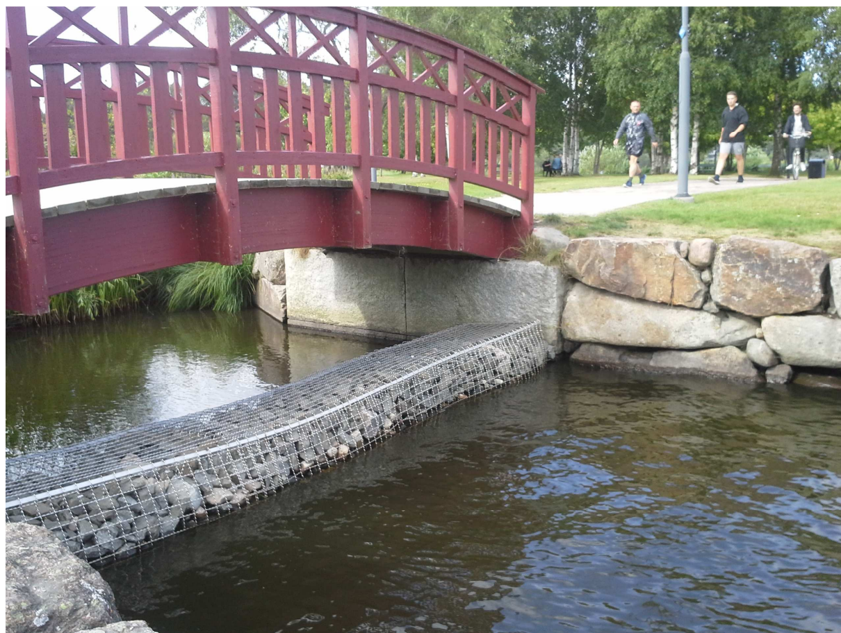
Foto 1. Nytt utlopp från Lagunerna till Växjösjön som förhindrar återmigration av vitfisk från Växjösjön.
